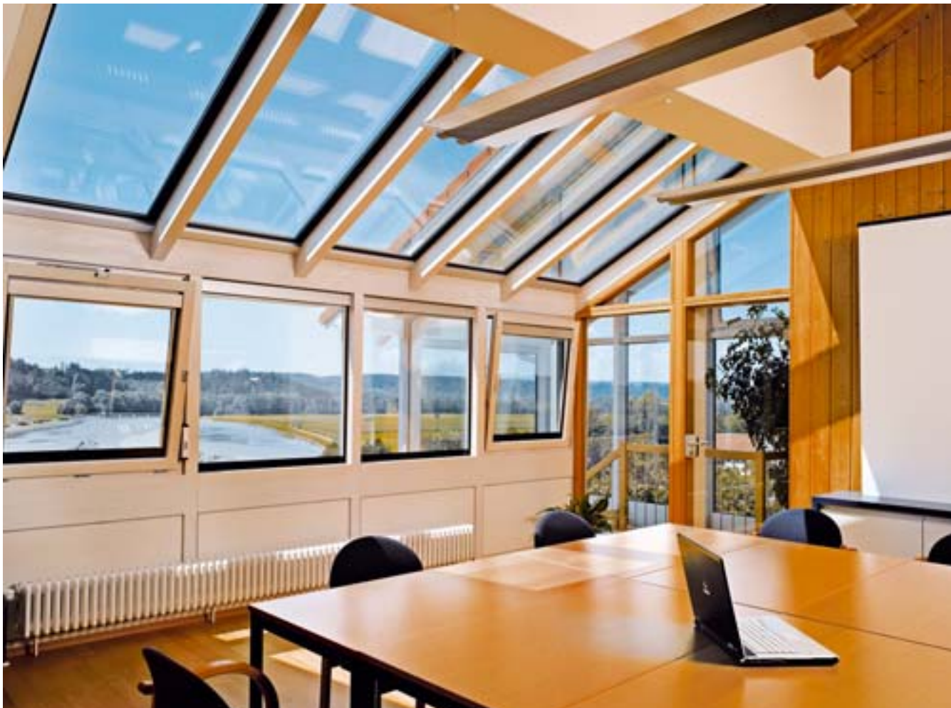
Der Schulungsraum im DG: die Fenster lassen sich zur Lüftung elektromotorisch öffnen und schließen
