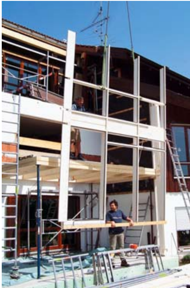
Mit Hilfe eines Autokrans werden die Fassadenelemente montiert
