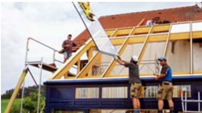
Einsetzen der Scheiben in die Sparrenfelder
