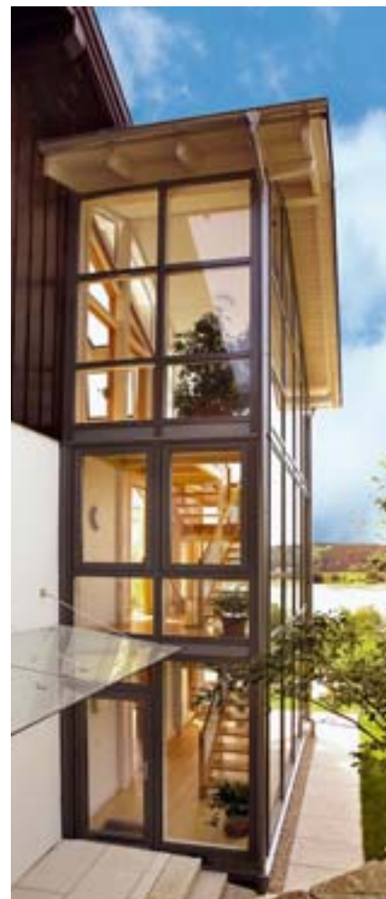
Treppenhaus von Norden
