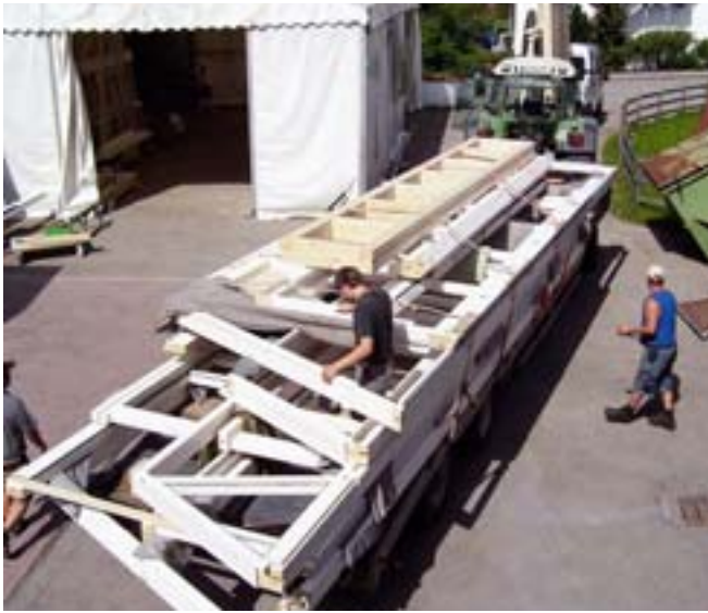
Die Montage der vorgefertigten Teile erfolgte wegen der Größe in einem Zelt
